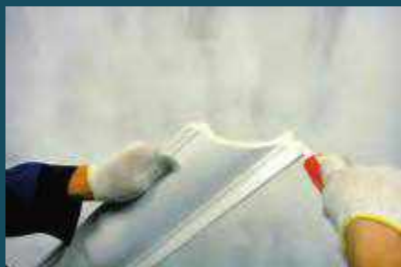
5. На торец изделия нанесите стыковочный клей
