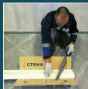
Монтаж лепного декора
