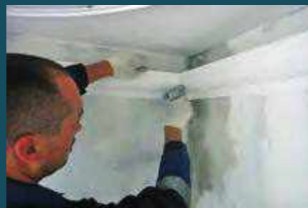
7. Место стыка зафиксируйте строительным степлером
