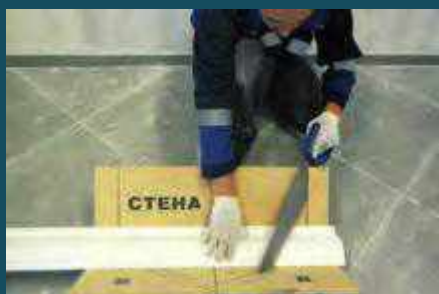
2. Отпилите фрагмент изделия требуемой длины с помощью столлярного стусла
